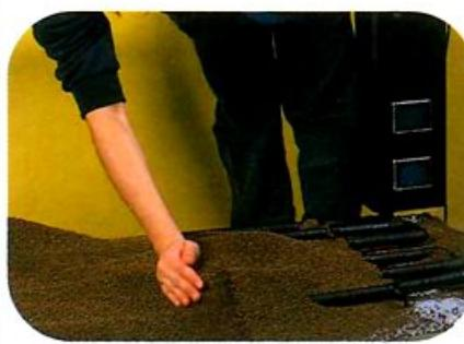
注意！撥土時，避開導流管上的孔隙，防止堵塞的情形發生而影響了過濾的效能；
